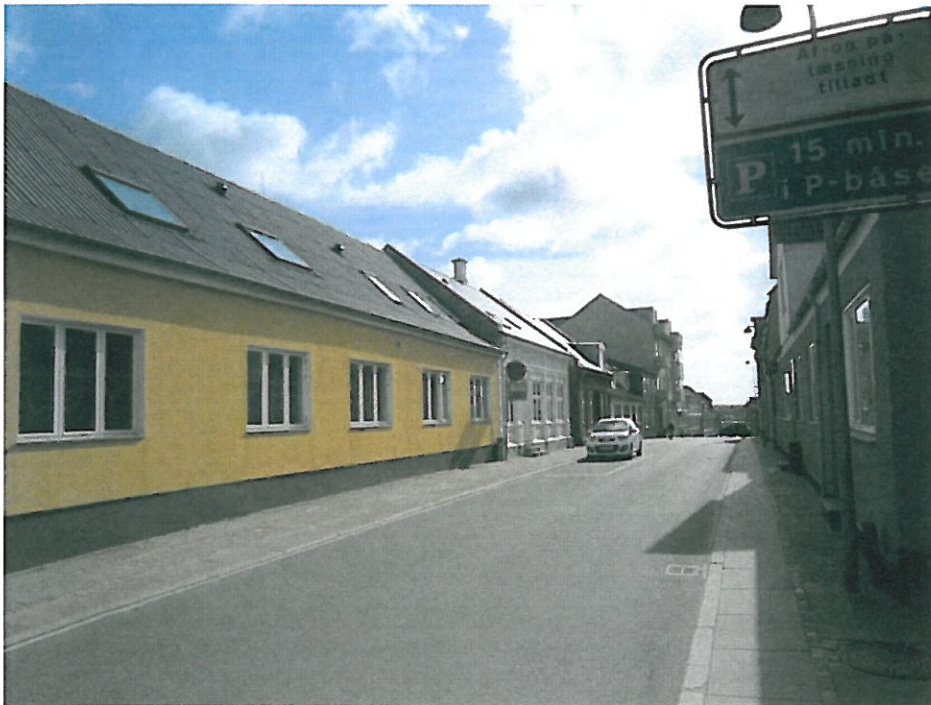
Bygning 1 (facade mod Storegade)
